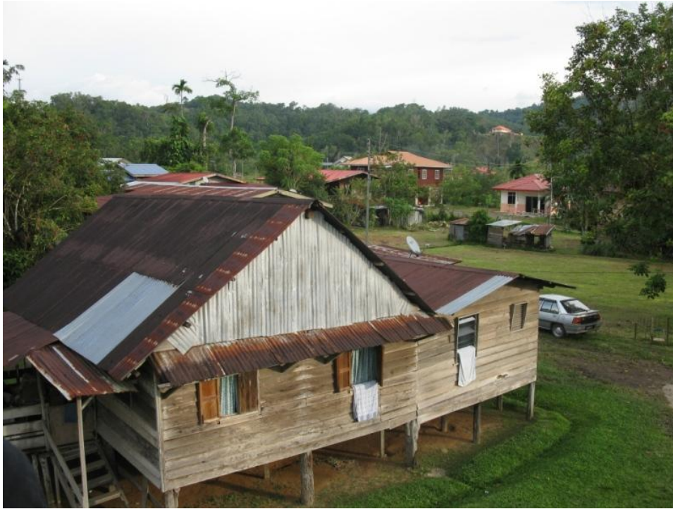
照片一、Kadazan-Dusun 的傳統建築－高腳屋
